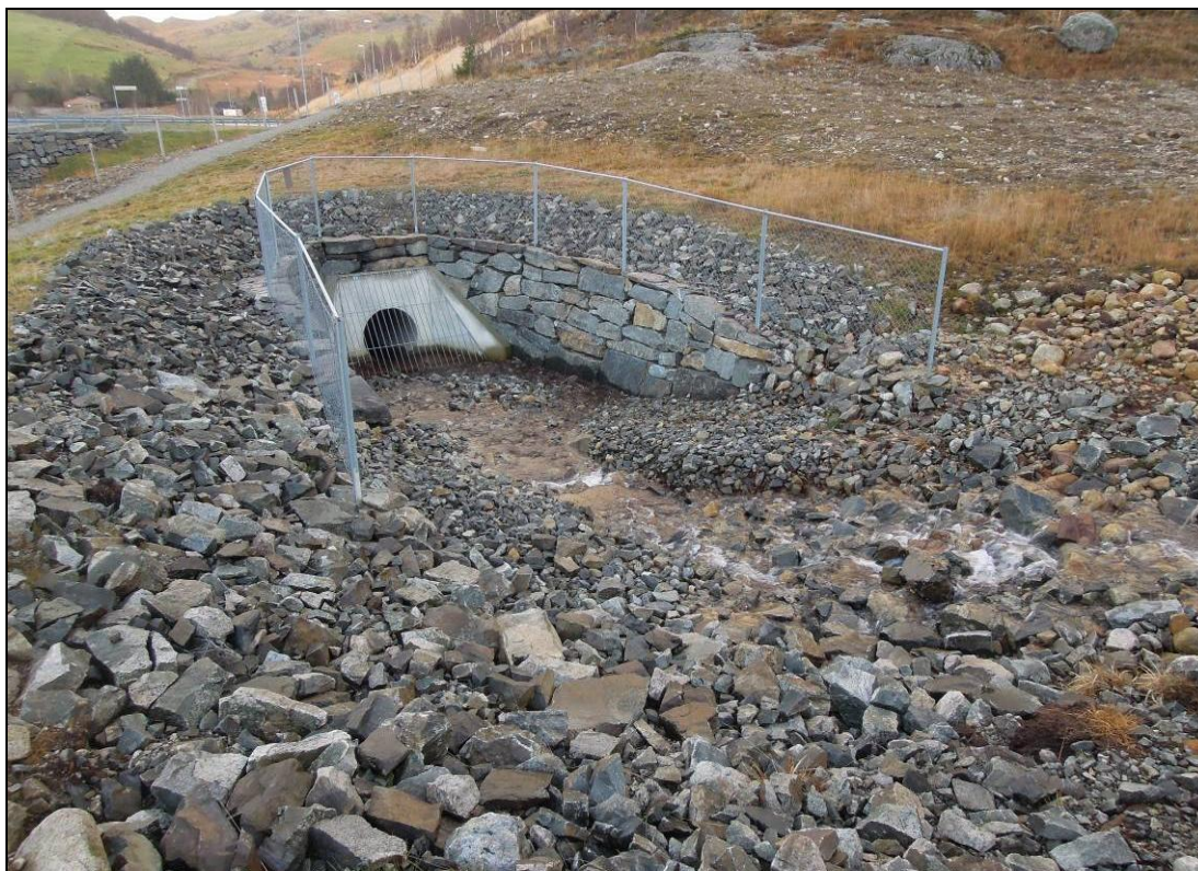
Figur 6.11. I østre kanten av planområdet går bekken ned i en kulvert. Foto: Leif Appelgren.
